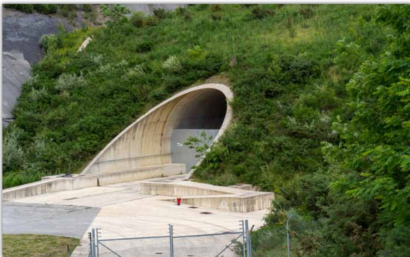
Antonio García-Bykofoto. Sucesión de túneles y estructuras en territorio accidentado.
