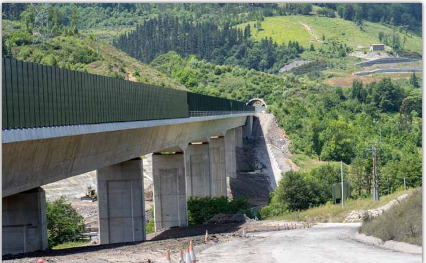
Antonio García-Bykofoto. En territorio accidentado y de gran valor ambiental, sucesión de viaductos y túneles.
