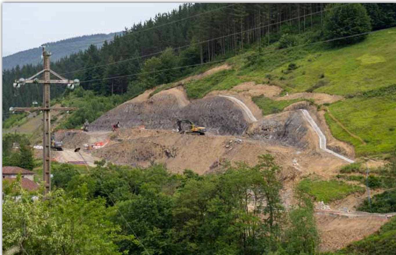
Antonio García-Bykofoto. Importante excavación a media ladera para conformar la infraestructura.
