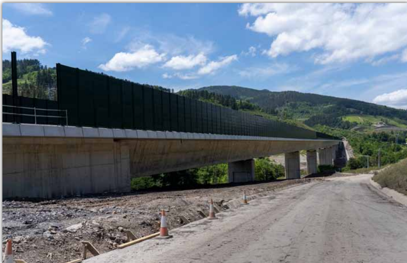
Antonio García-Bykofoto. Sucesión de viaductos y túneles para conformar la infraestructura del ferrocarril.
