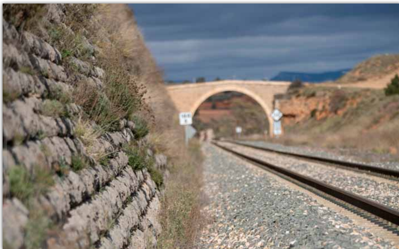
Antonio García-Bykofoto. Pared de mampostería/sillería con manifiesta vegetación (jardín vertical).
