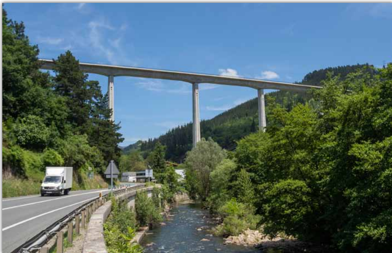
Antonio García-Bykofoto. Pilas de viaducto de gran altura.
