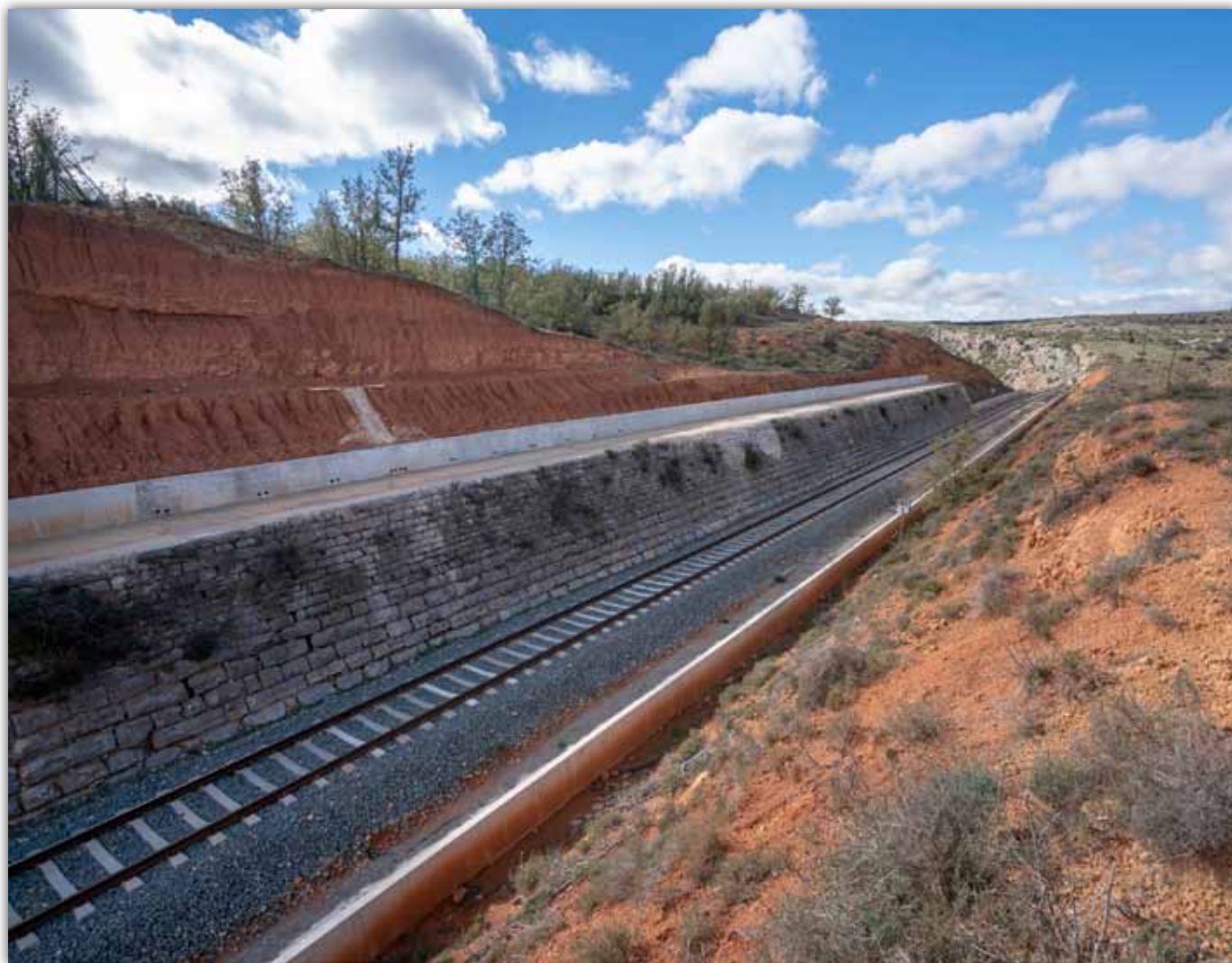
Antonio García-Bykofoto. Trinchera restaurada. Se corresponde con la zona de deslizamiento que provocó el descarrilo en 2015.
